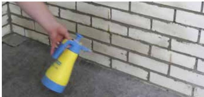
**1** Nakon što su duboke pukotine i površinske nepravilnosti izravnate s KÖSTER Reparturnim mortom, područje se premaže s KÖSTER Polysil TG 500.
