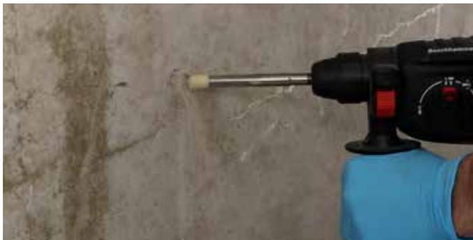
**1** Izbušiti rupe duž toka pukotine na naizmjeničnim stranama na udaljenosti od cca. 10-15 cm i pod kutom od cca. 45° prema pukotini.
