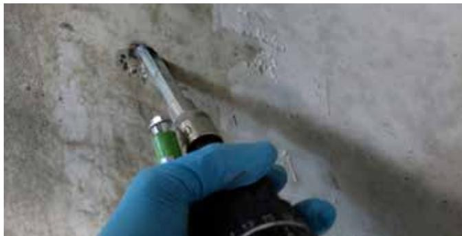
**2** Instalirajte KÖSTER Superpackere u svaku drugu ili treću bušotinu. Nezatvorene bušotine omogućuju oslobađanje tlaka tijekom injektiranja.
