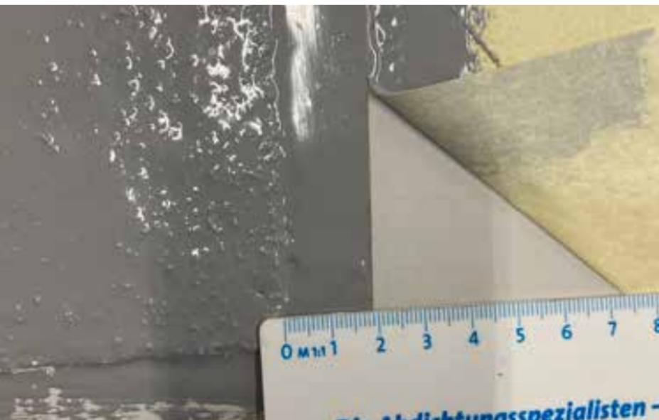
Na rubovima, hidroizolacija mora u potpunosti prekriti flis i izlaziti minimalno 2 cm.
